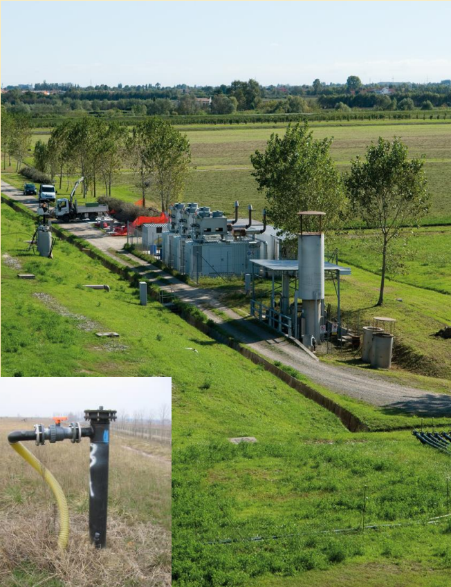
Motori per recupero energetico e pozzo di captazione biogas
