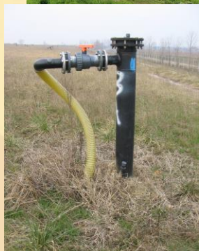
Motori per recupero energetico e pozzo di captazione biogas
